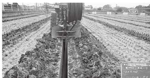
▲暗渠排水工事
