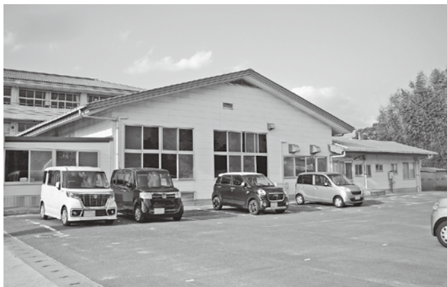
▲今後集約される予定の三日月小学校給食室
