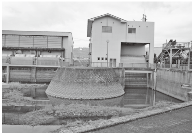
▲大雨、豪雨被害から地域を守る排水機場
