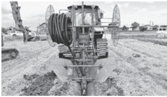
▲水田暗渠排水整備事業工事の様子
