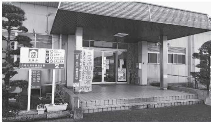
▲各地区に設置された避難所
