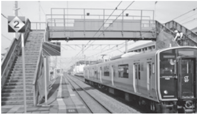
▲屋根もエレベーターもない跨線橋（牛津駅）
