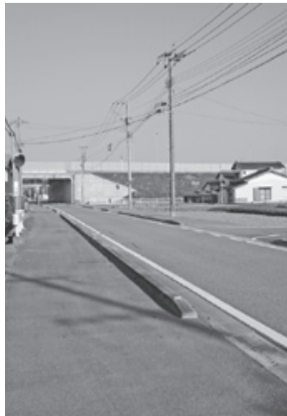
▲有明海沿岸道路を緊急避難場所に指定は？
