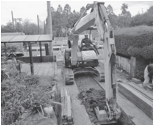
▲下水道整備が進む小城市中心市街地
