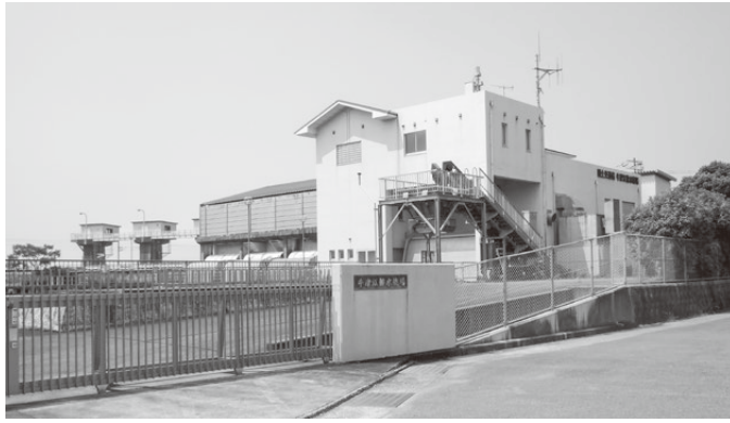
▲牛津江排水機場
