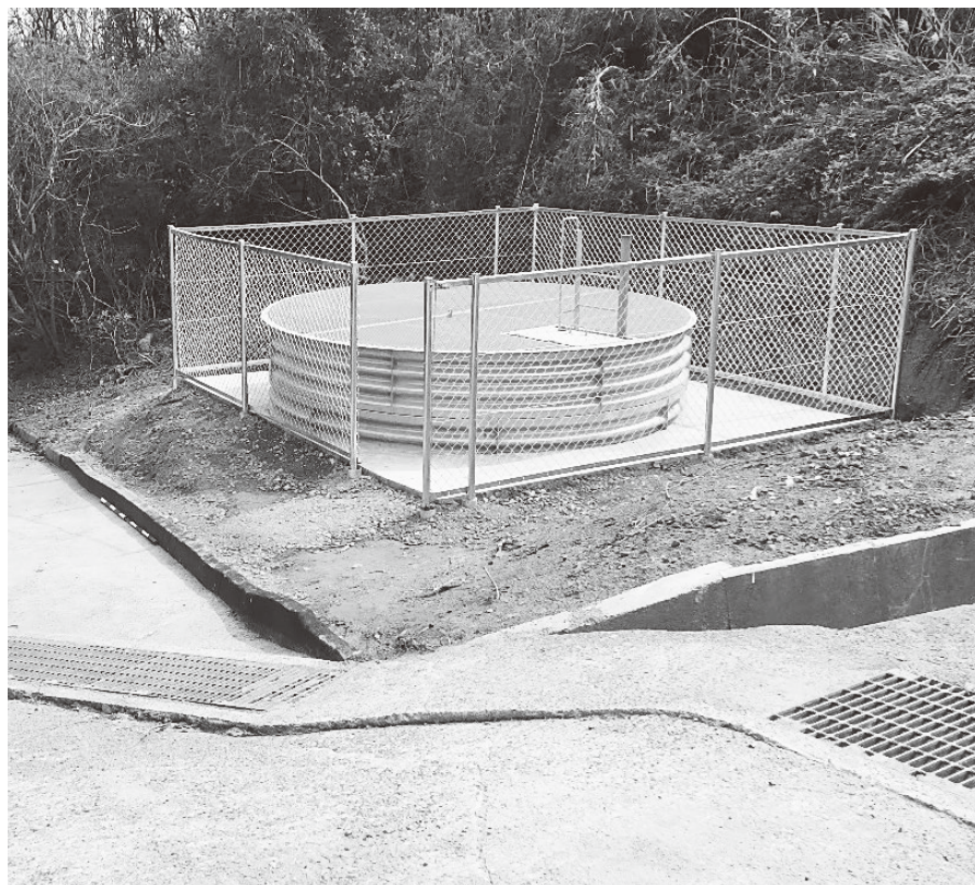
▲地滑り対策として集水井を2か所設置 (西分)
