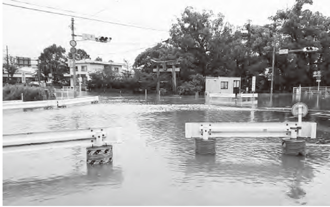
▲被災状況 牛津町江津交差点
