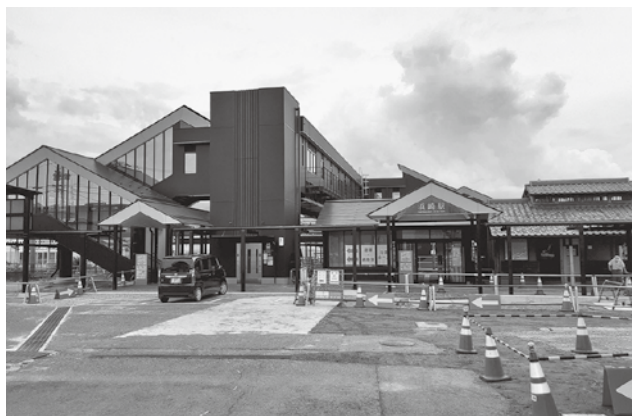
▲新設された唐津市浜崎駅の南北自由通路
