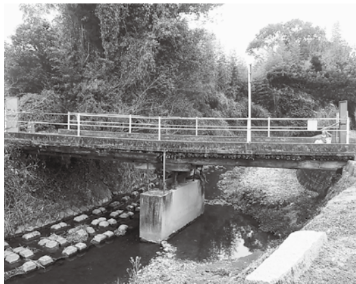
▲架け替え工事予定の安心橋（小城市）
