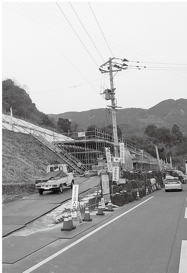
▲復旧が進む災害現場
