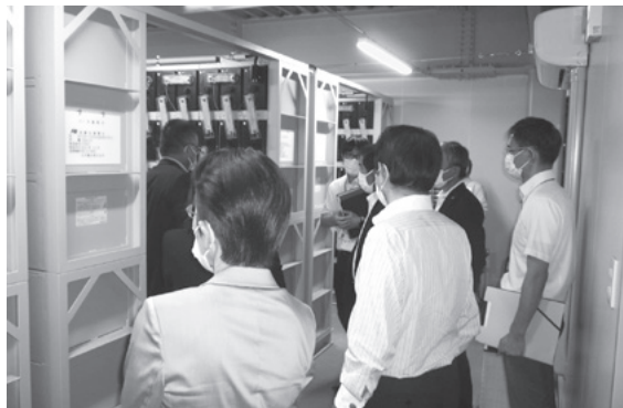
▲庁舎防災機能強化事業の運用状況
