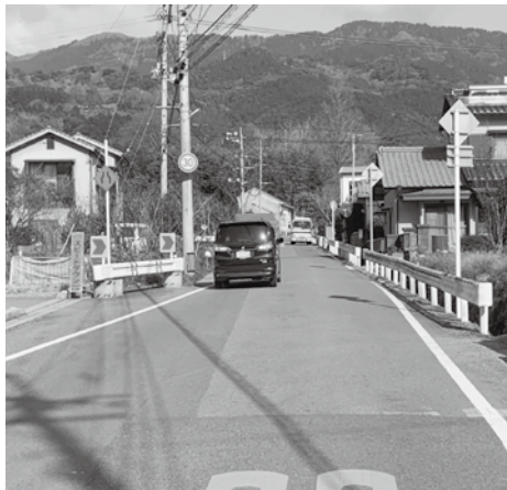
▲早期拡幅が望まれる県道
