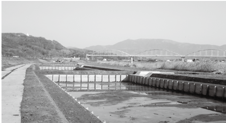
▲牛津川湛水池工事(牛津町下砥川地区)
