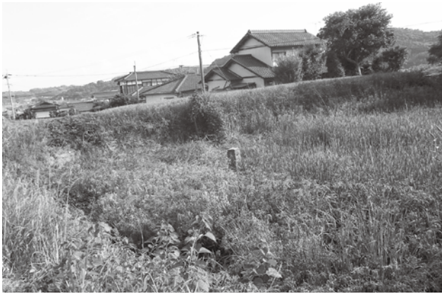
▲寺浦第3ため池、水位調整用の樋が見える
