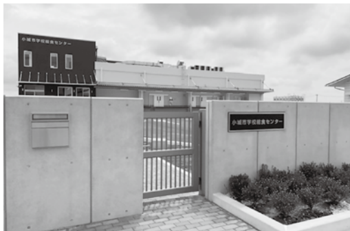
▲建設が進む小城市学校給食センター
