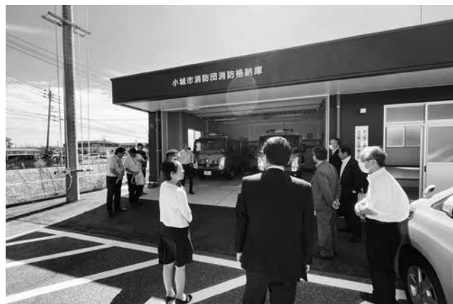
▲小城市消防団芦刈分団拠点格納庫
