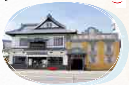
▲(右)旧砂糖貯蔵庫 (村岡総本舗羊羹資料館) (左)村岡総本舗本店
