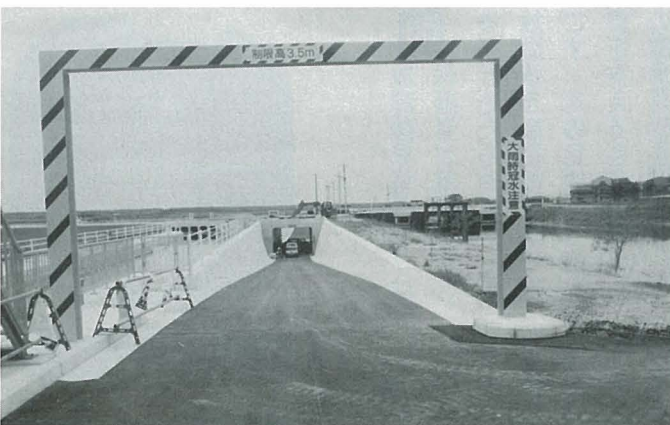
▲江北～芦刈線に新設されたアンダーボックス (牛津町永田地区)
