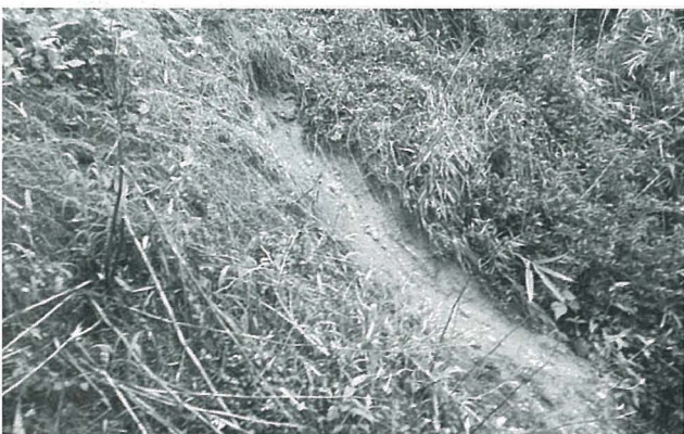
▲土砂災害の現場
