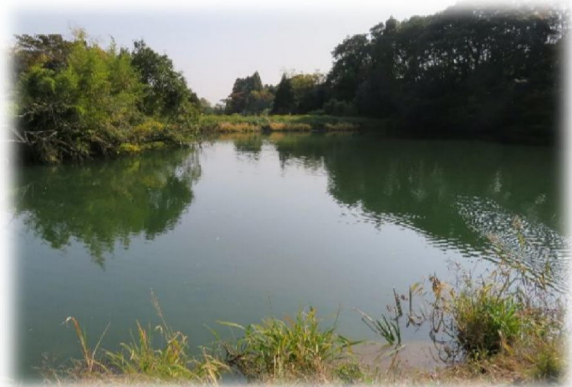
西分第1ため池
