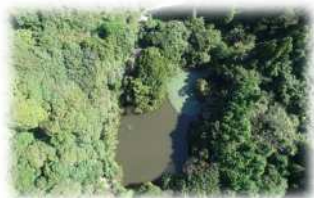
寺浦第1ため池全景
