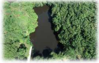
永祥庵ため池全景
