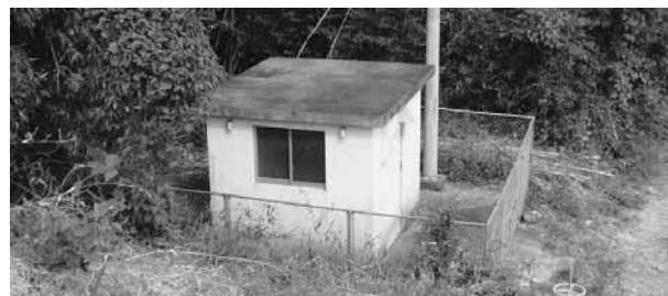
▲川越城第一揚水機場
