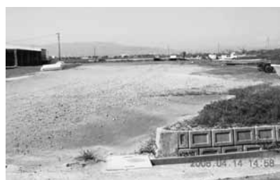
▲ノリ共同加工工場建設予定地(芦刈町新村)
