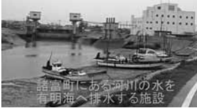
福所江水門と排水機場と同じ機能の 県管理の新川水門と排水機場
