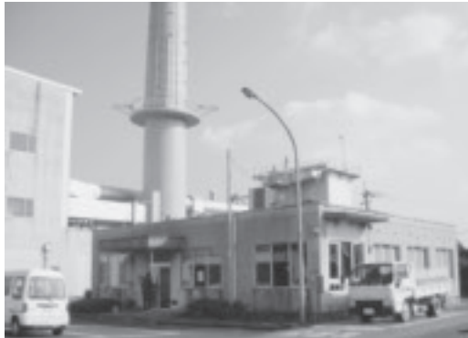
▲天山塵芥処理場
