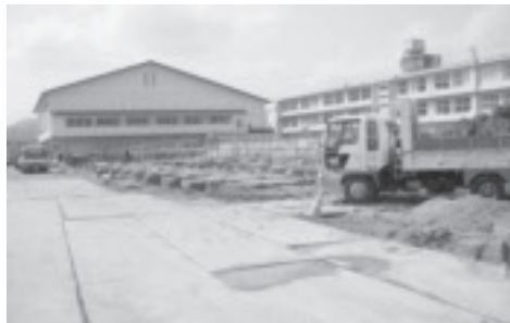
▶改築が進む牛津中学校
