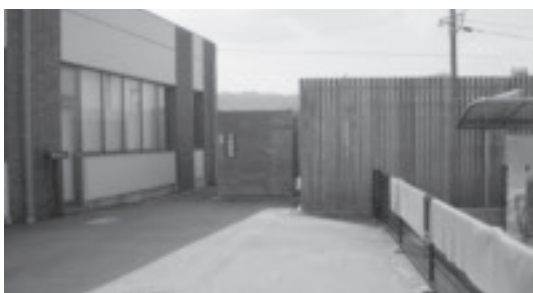
▶アイルでガス除去工事が行われる
