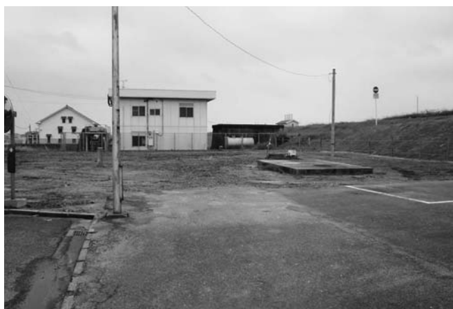
応急的廃棄物中継センター建設予定地
