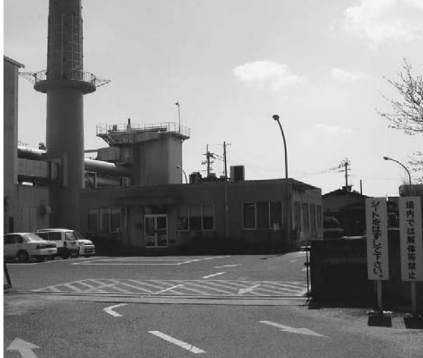
▲老朽化が進む天山塵芥処理場
