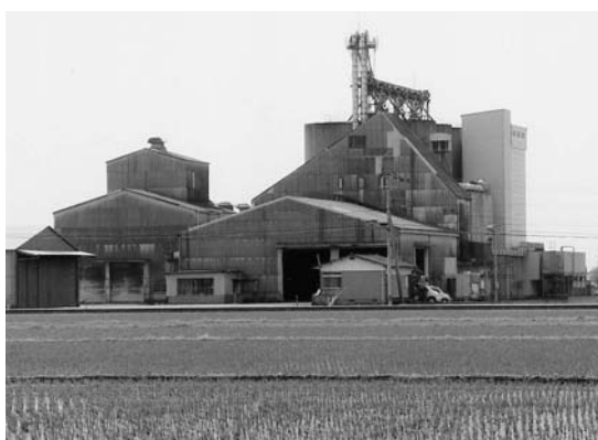
▶建て直される 三日月カントリーエレベーター
