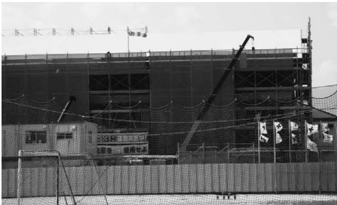
▶工事が進む牛津中学校
