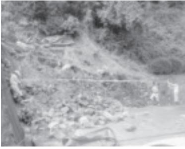
▶崩落した中善寺急傾斜地
