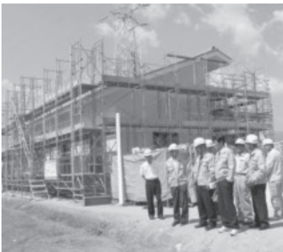
▲堀江農業集落排水処理場視察
