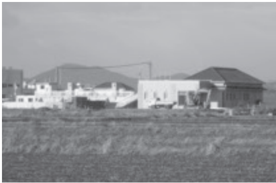
▲H22.3月共用開始される下水道 芦刈浄化センター
