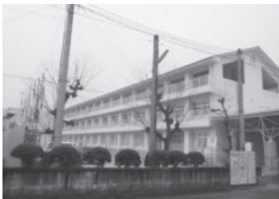
▲建設中の牛津中学校
