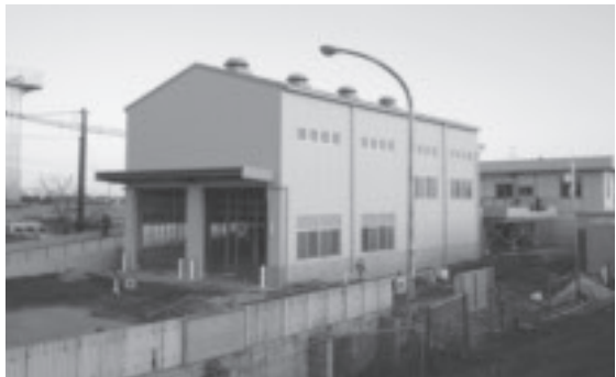
▲一般廃棄物中継応急対策施設
