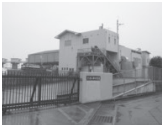
▲牛津江排水機場
