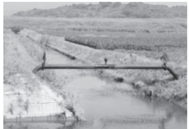
▲地域農業水利施設ストックマネジメント事業
