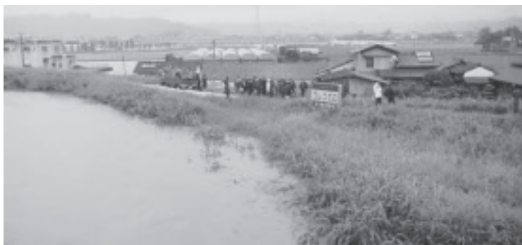
▲氾濫危険の牛津川
