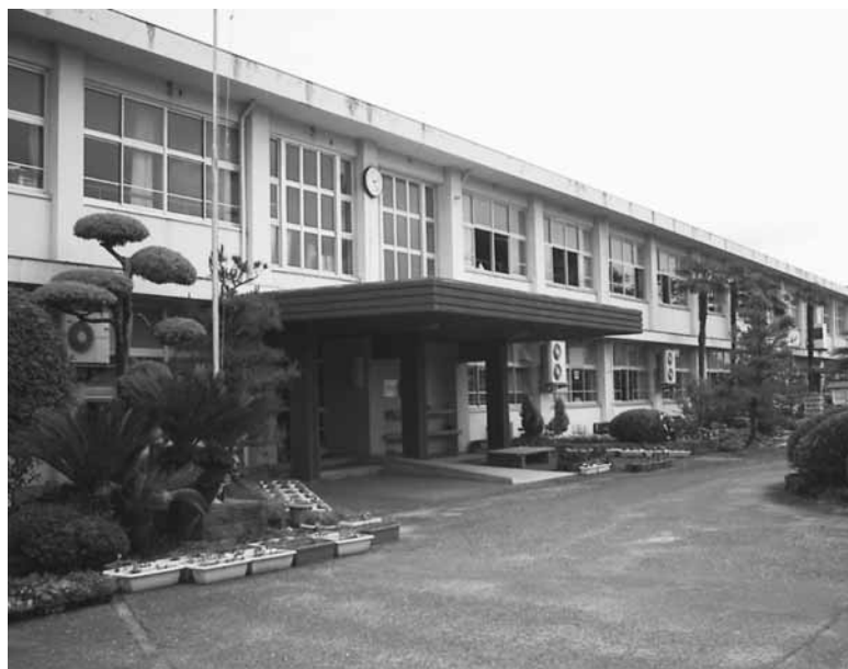
▲改修が予定される芦刈小学校
