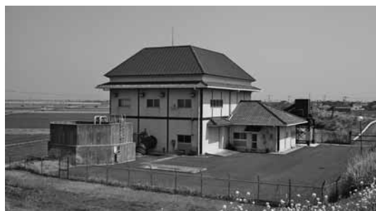
▶芦刈の第二排水機場
