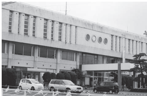
▲本庁舎移行が予定されている三日月庁舎
