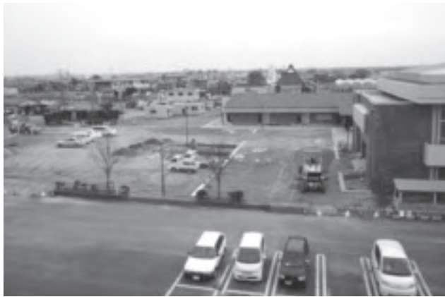
▲整備が進む芦刈交流センター
