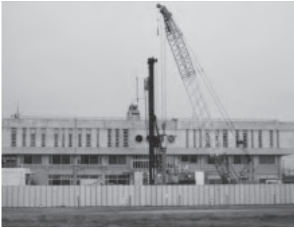
▲本庁舎増改築建設風景
