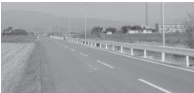
▲整備された防犯灯
