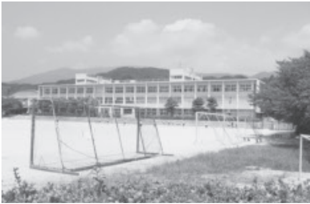
▲改築される小城中学校
