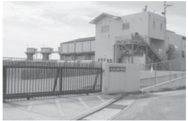
▲牛津江排水機場
