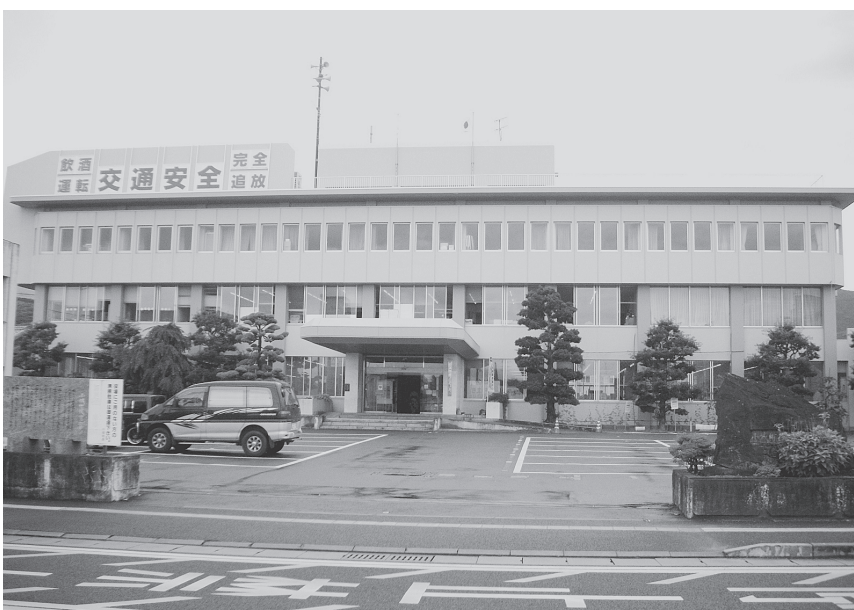
▲市民交流プラザの建設が予定されている小城庁舎
