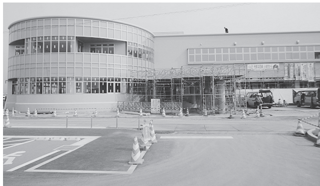
▲完成間近な本庁舎
