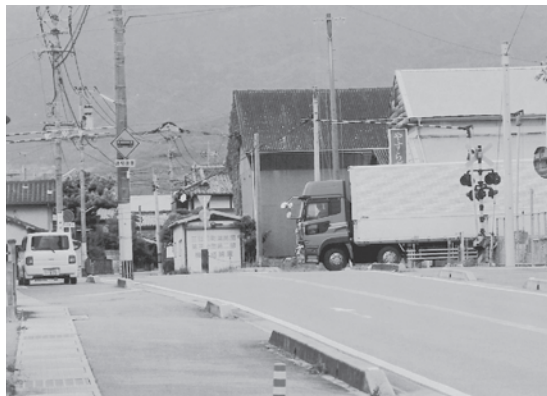
▲改修が待たれる県道小城牛津線の甘木踏切
