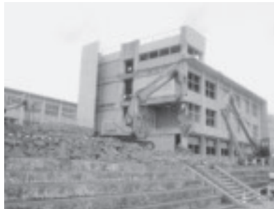
▶小城中学校の解体作業
