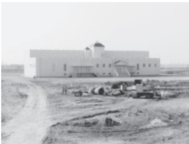
▲建設が進む公共下水道 三日月処理区の浄化センター
