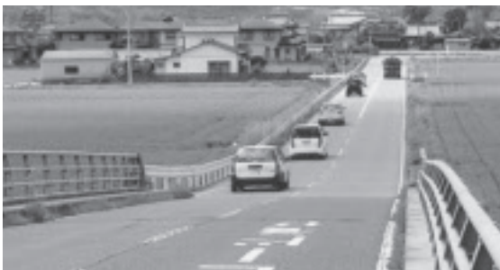
県道昇格が待たれる市道三ヶ島・大和線
