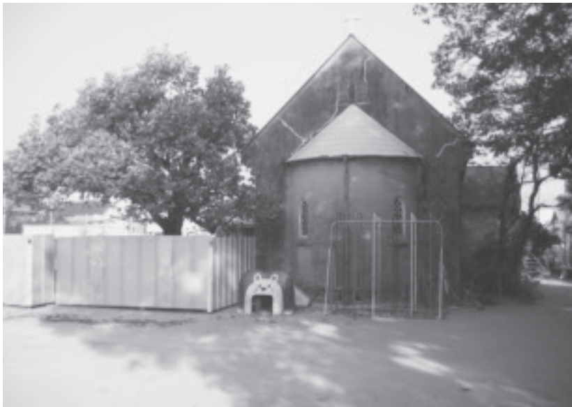
▲改築工事が始まった小城幼稚園
