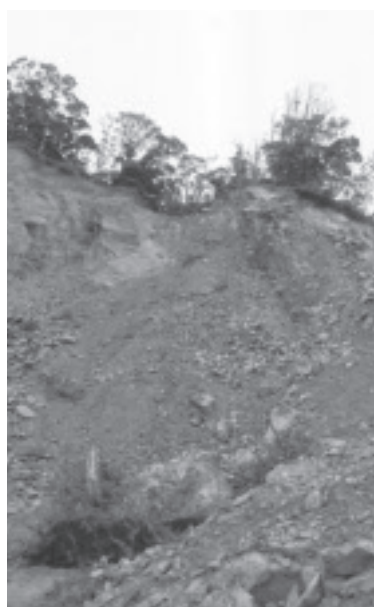
▲崩落が続く松本山採石場
