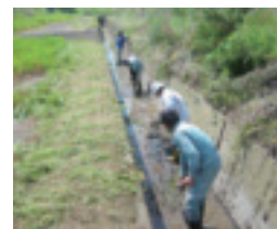
水路清掃作業
