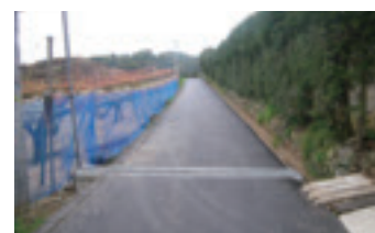
小城町山崎地区農道（一部改修後）
