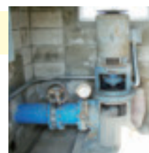
揚水機（改修前）
