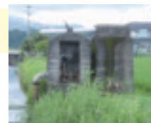
揚水機（改修前）
