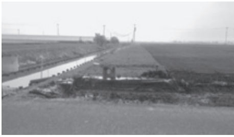
▲水路浚渫された泥土の状況
