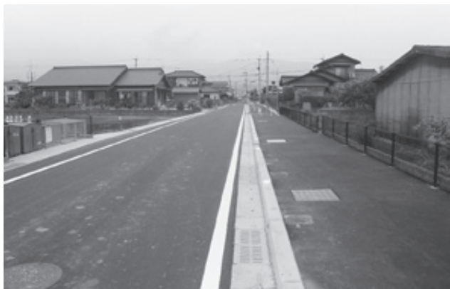
▲道路改良中の市道江利・大寺線
