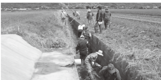
▲地域活動による水路整備
