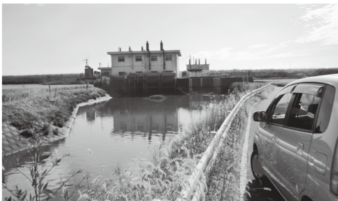
▲排水能力アップを求められる満神排水機場
