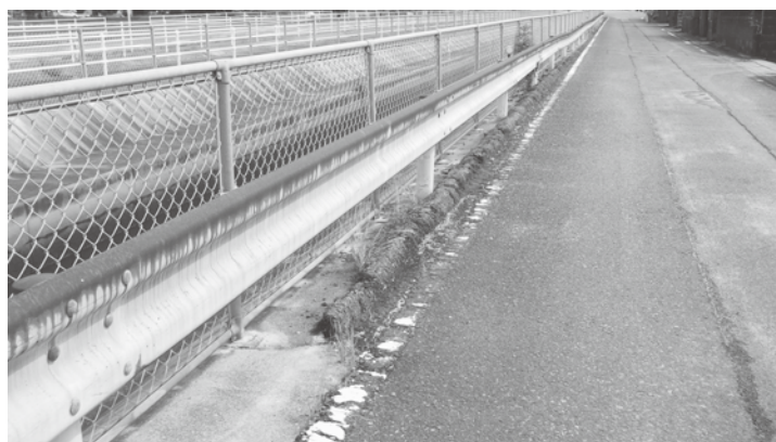
▲以前は設置されていた生立ヶ里のアスカーブ
