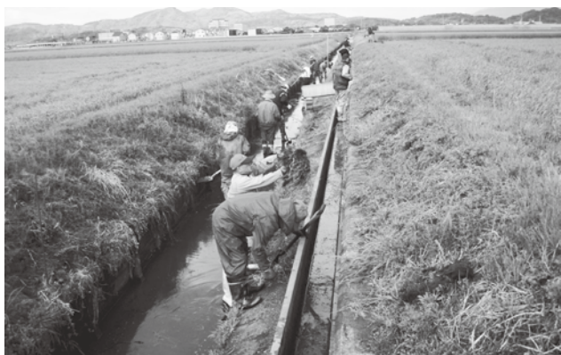
▲多面的機能支払い交付金による整備中の水路
