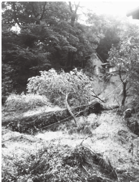
▲山間地帯における土砂災害状況
