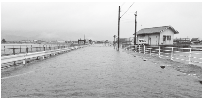
▲大雨時通行止めとなった県道牛津川上線(牛津町乙柳地区)
