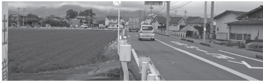
▲両側歩道での整備が望まれる県道小城市津線
