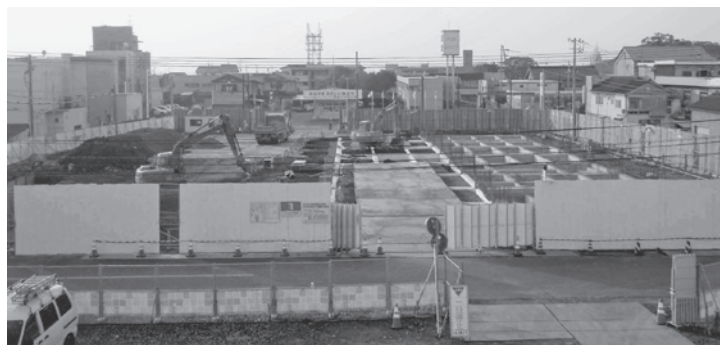
▲建設中の交流プラザ
