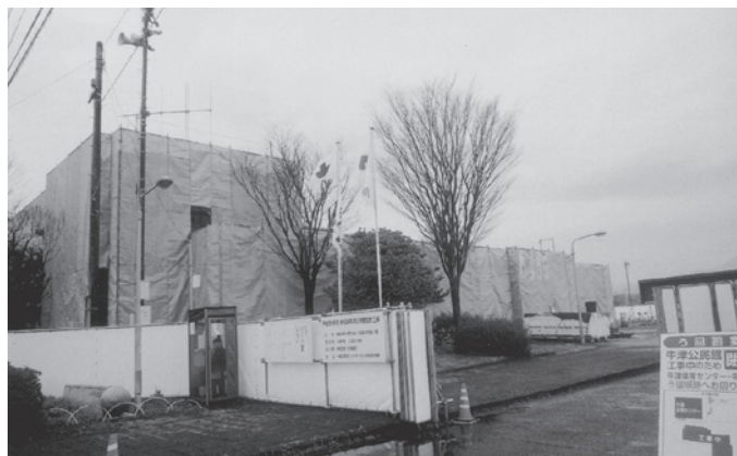
▲完成が待たれる改修中の牛津公民館(旧議会棟)
