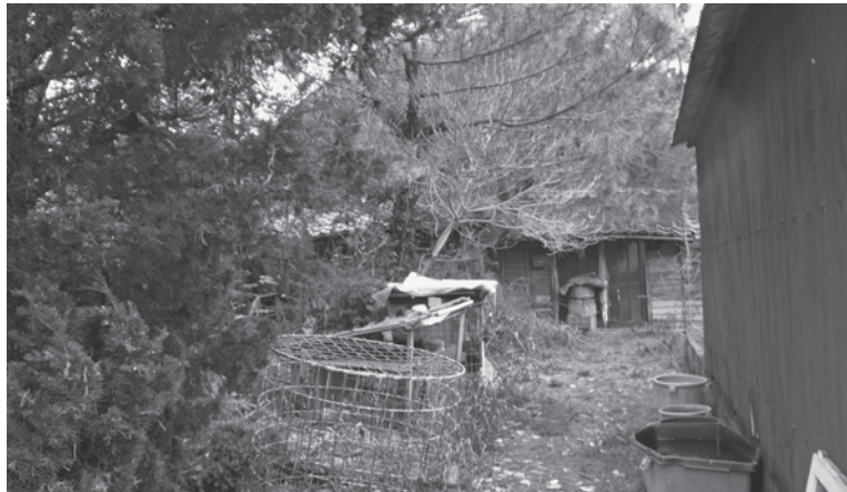
▲放置されている空き家
