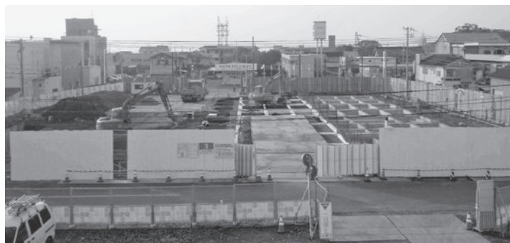
▲建設中の交流プラザ
