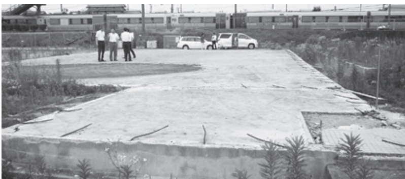
▲基礎部分が残っている建設予定地
