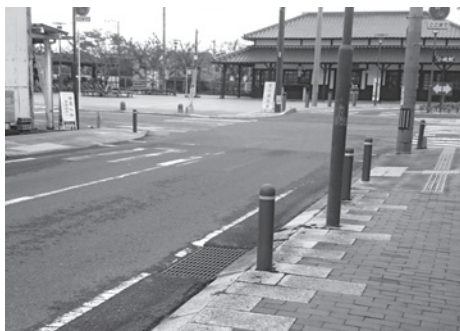
▲横断歩道が消えかかって危険な交差点
