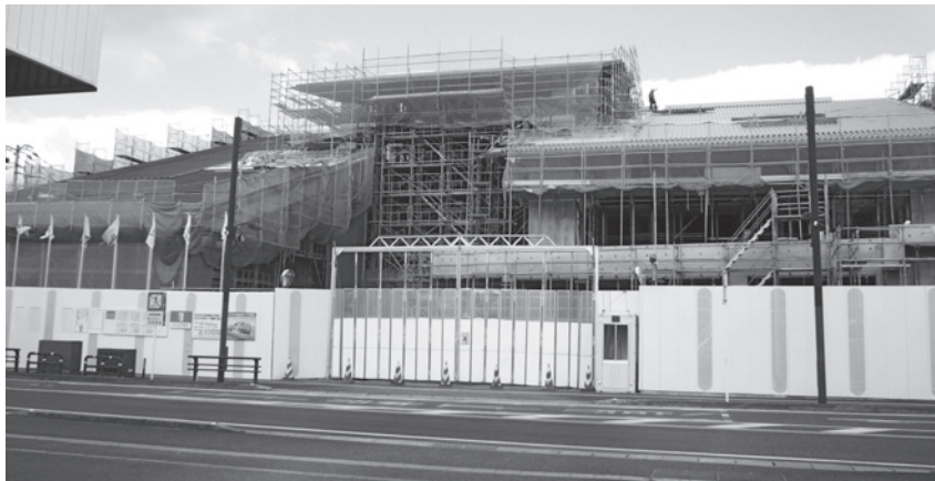
▲完成が遅れ、まだ足場が残る交流プラザ（9月現在）
