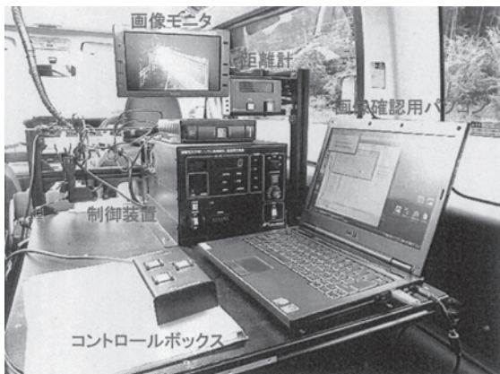
▲路面性状調査のための測定車（車内）
