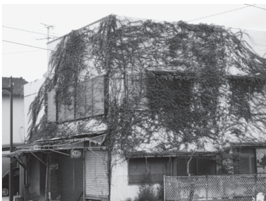
▲道路沿いの空き家
