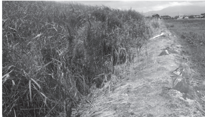
▲国の一級河川堤防沿いの整備されていない堤脚水路
