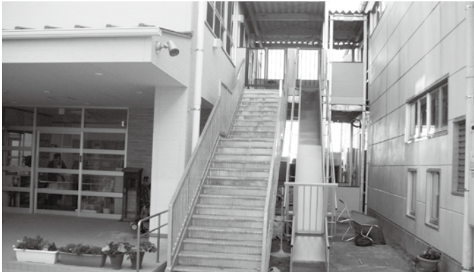
▲避難設備は安全第一
